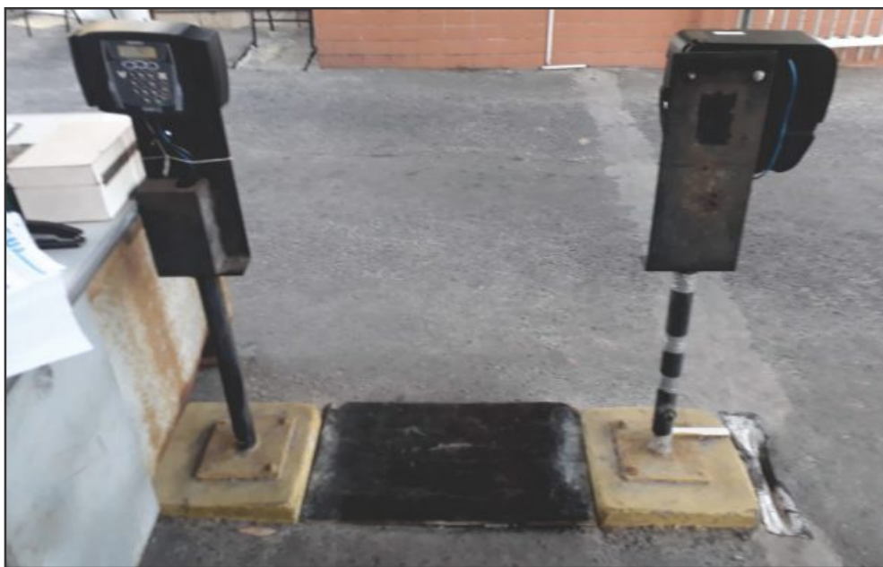
▲ Em lugar de uma tampa de cimento, deram um jeitinho com uma tampa de madeira...
