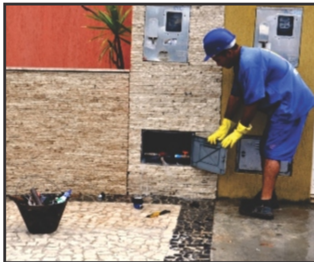
Muitas ligações estão sendo feitas de qualquer jeito
