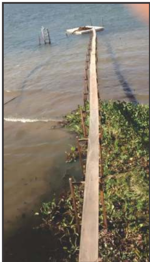
DO BOLSO | Em Ilha das Flores, trabalhadores construíram acesso até à balsa flutuante
