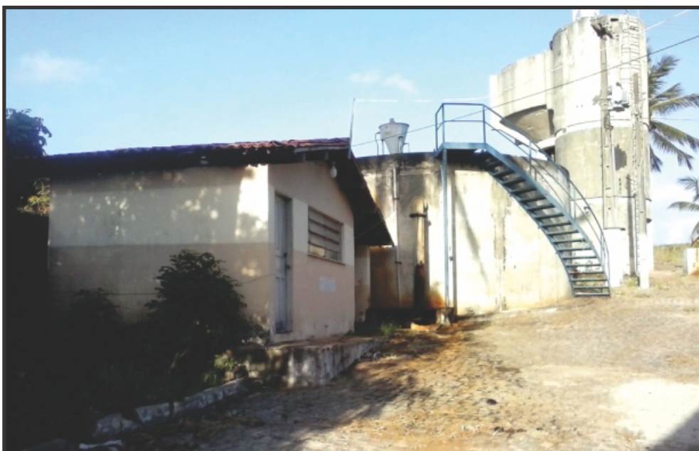
▲ Estação de Tratamento de Pirambu: segurança paga pelos próprios trabalhadores
