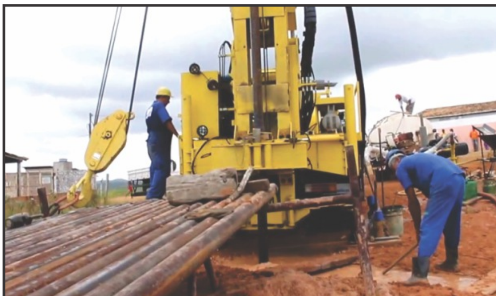
▲ Pela característica do trabalho de perfuração, trabalhadores não podem parar o serviço
