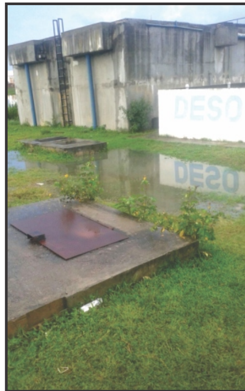
▲ Nos finais de semana, os arredores da ETE Rosa Elze é um rio de esgoto
