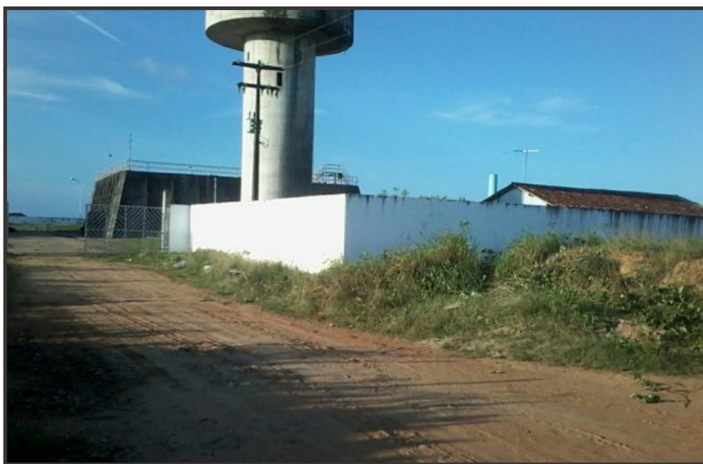
▲ Unidade é isolada e não tem quase que nenhum proteção contra invasores indesejáveis
