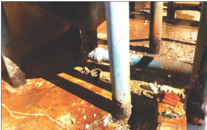
▲ O alto grau de corrosão nas estruturas dos filtros põe em risco a vida dos operadores da ETA Lagoa Redonda
