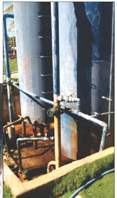
▲ O alto grau de corrosão nas estruturas dos filtros põe em risco a vida dos operadores da ETA Lagoa Redonda
