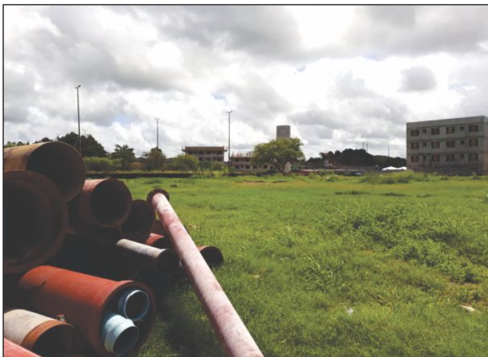
▲ Na ERQ Sul, tubulações acumuladas como sucata e condomínio crescendo no entorno
