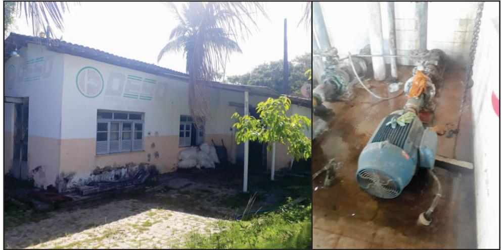
▲ Realidade da Captação: estrutura física comprometida e bombas com vazamento
